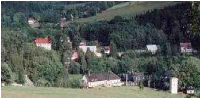
-Teilansicht Grenzübergang Georgendorf
